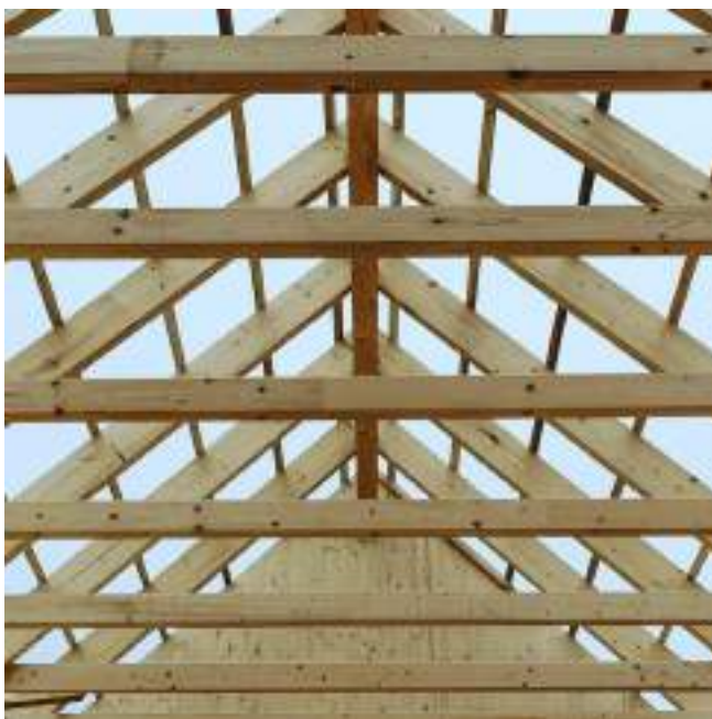
KROV TESAŘSKÝ ZHOTOVENÝ
